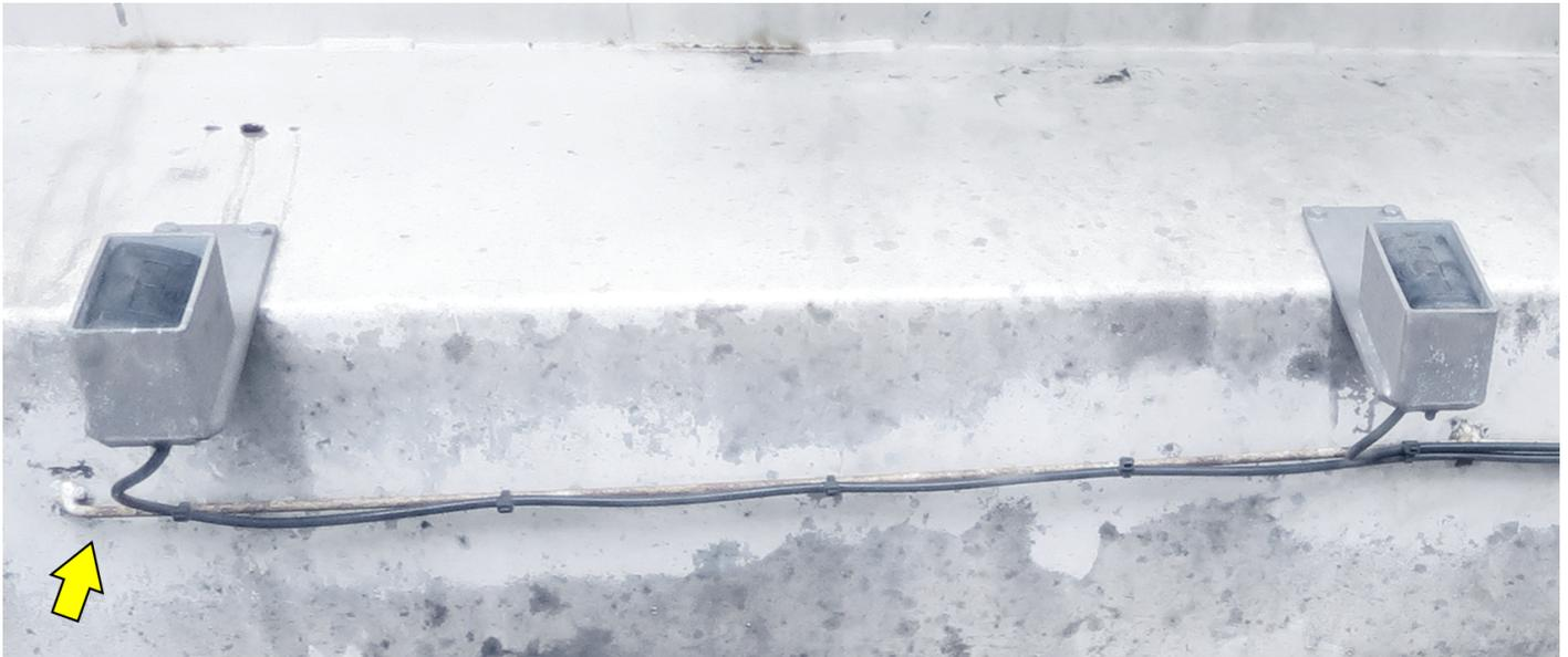
Die Steckkupplungen der Sensorkabel sollten in geschützten Bereichen verbaut werden, zum Beispiel wie hier hinter einer Abdeckung der Schüttung:
